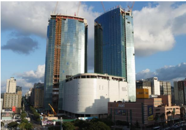
그림 9. 제주드림타워 건설 현황
