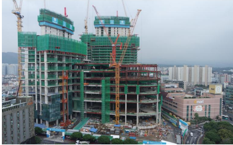
공사 현황 (2018.11.12 기준)
